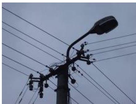
Elektrifikácia v obci
